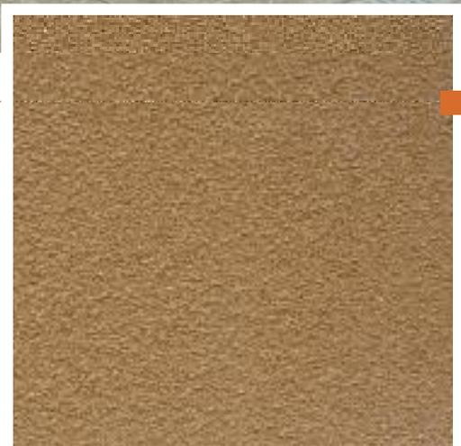
Detail des Finishes des Spray béton
