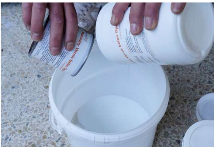
Gießen Sie die 2 Komponenten des Optimum-Lackes nachdem sie in einem sauberen Eimer gewogen wurden.
