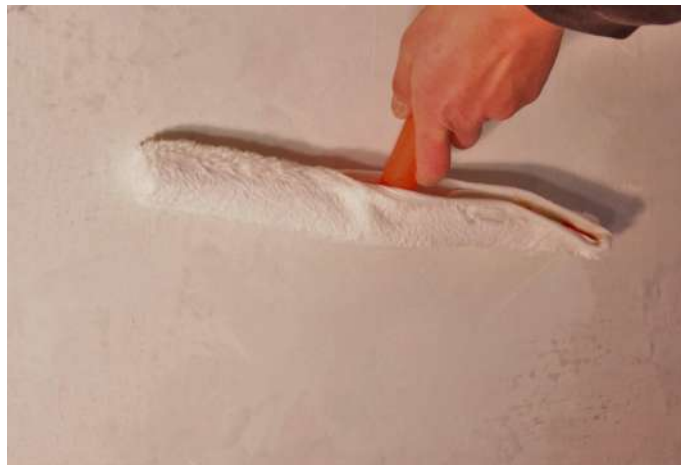
Tragen Sie Wachs mit einem feuchten Tuch oder Besen auf und arbeiten Sie von unten nach oben.
