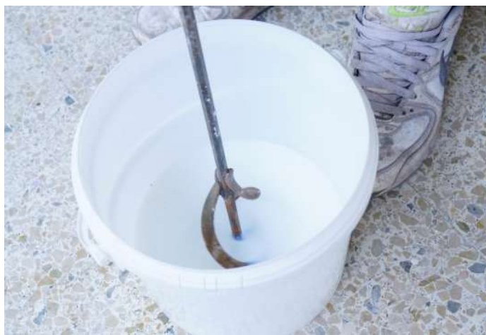
Mischen Sie die 2 Komponenten mit langsamer Geschwindigkeit für 1 Minute. Lebensdauer der Mischung +/- 45 mns abhängig von der Umgebungstemperatur.
