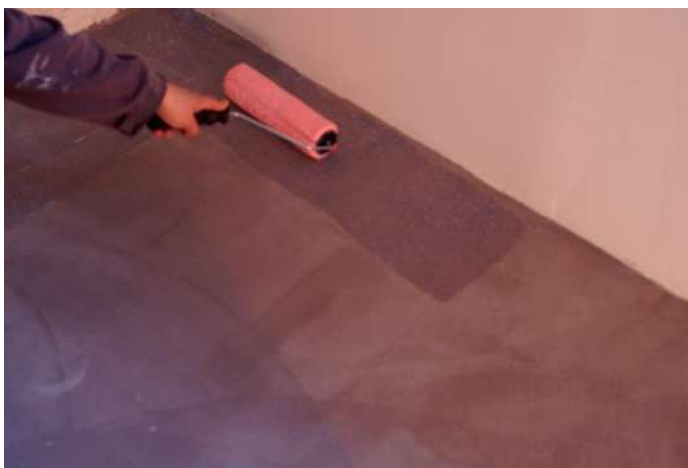
Nachdem Sie die Oberfläche bestäubt haben, tragen Sie die Mundporen auf. Verwenden Sie auf einer großen Fläche eine 500 mm Rolle oder einen Mikrofasermop. Lassen Sie 2 bis 4 Stunden trocknen.
